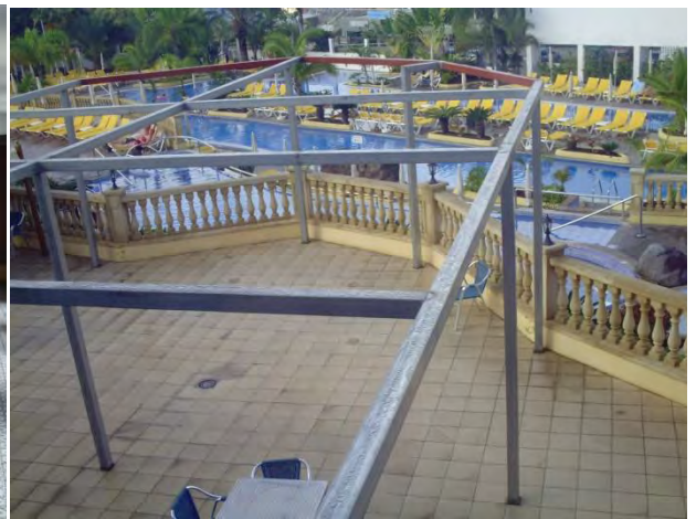
Konstruksjonen til "utvidelsen".
